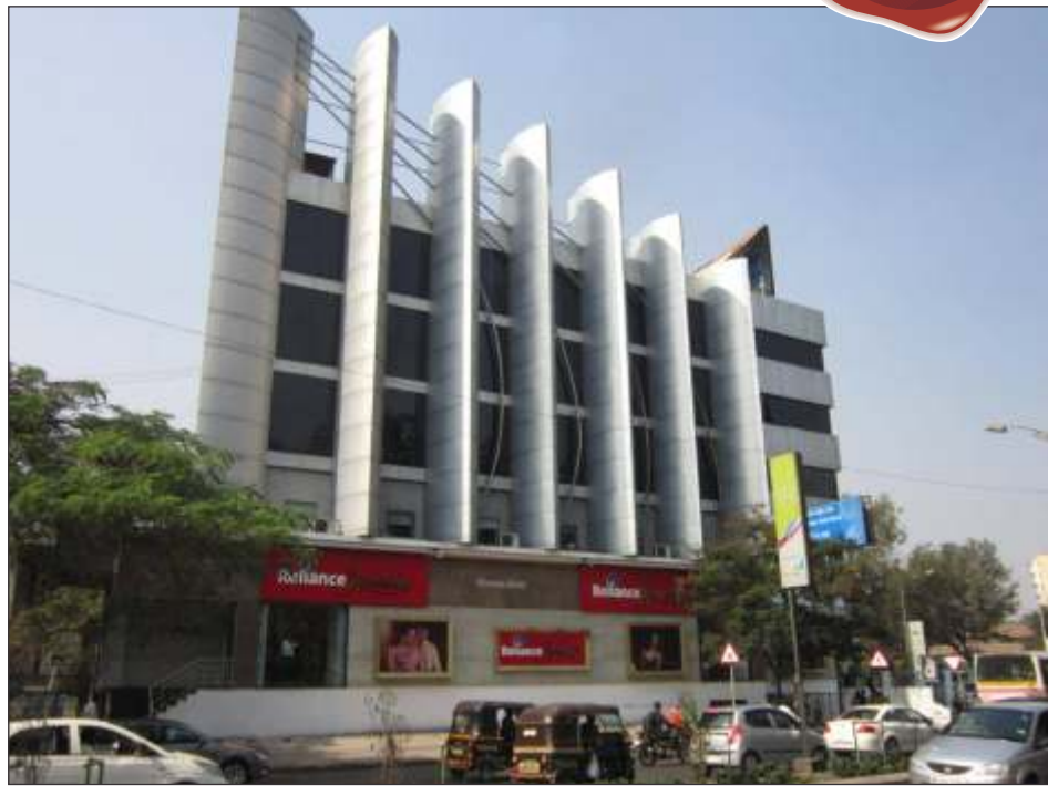
Actual Photograph – P. T. Gera Centre
