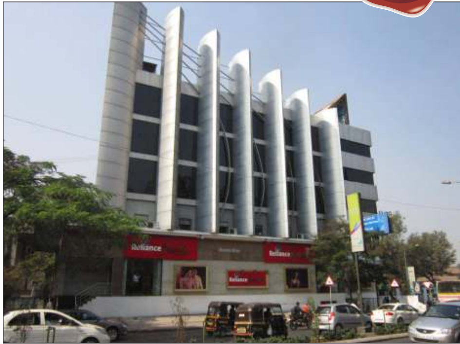
Actual Photograph – P. T. Gera Centre
