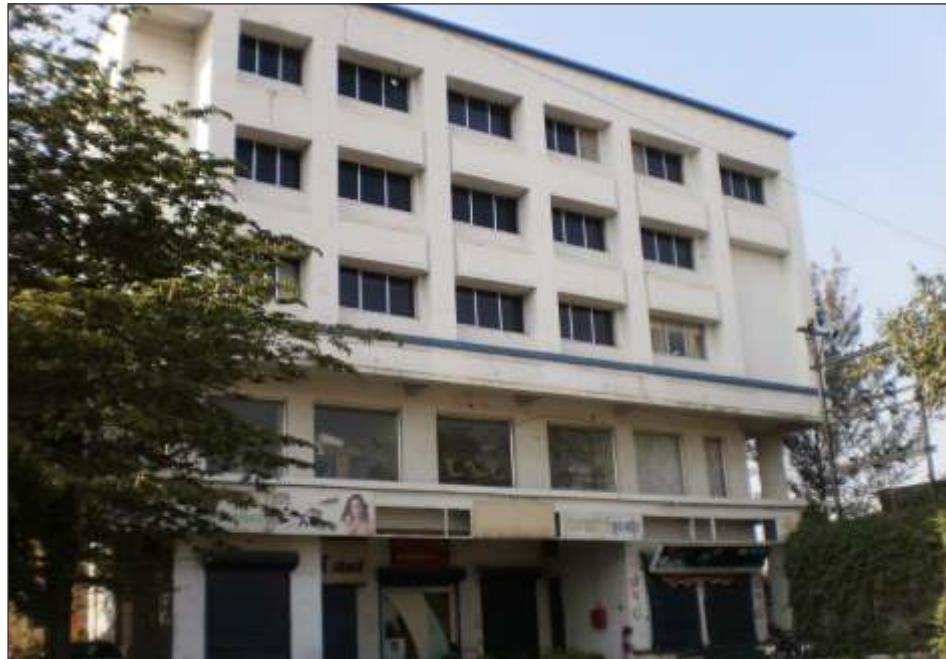
Actual Photograph – Shakti Chambers
