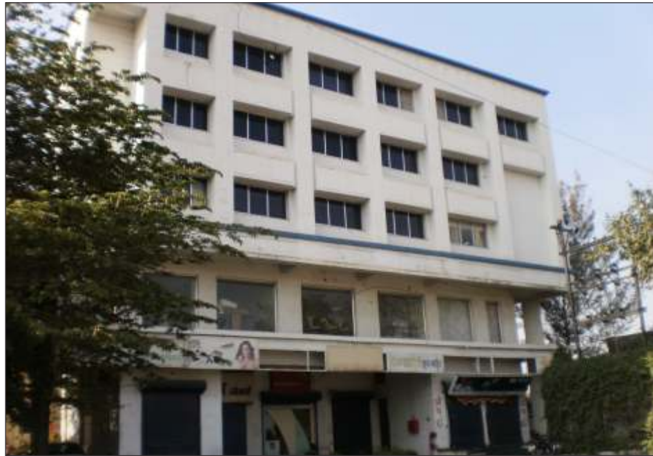
Actual Photograph – Shakti Chambers
