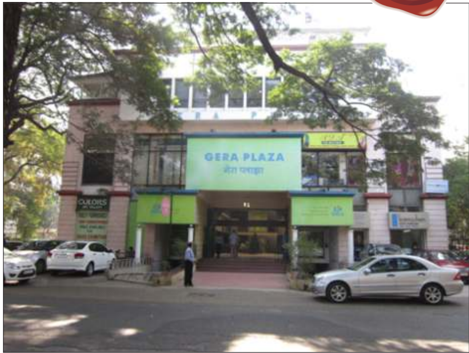
Actual Photograph – Gera Plaza
